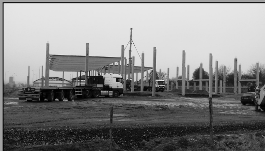
Výstavba konzervárny v průmyslové zóně
